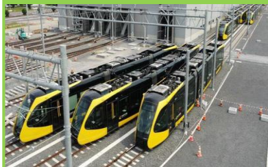
LRT車両基地
