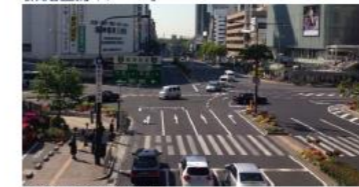
現状：車中心の道路空間
