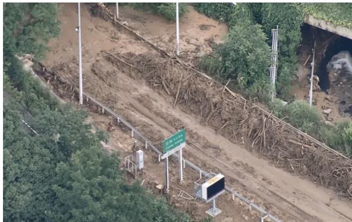
山陽自動車道 平成30年7月14日(土) 復旧
