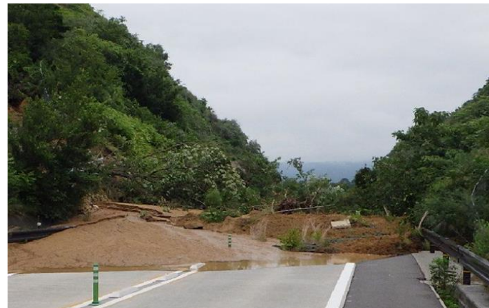
東広島・呉自動車道 平成30年7月10(火) 復旧
