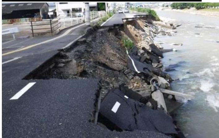
国道2号 平成30年7月21日(土) 復旧
